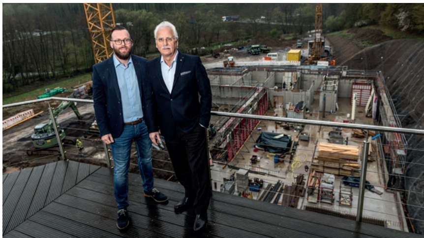
Ein weiteres Projekt von Thomas Rönnfeldt (l.) und Walter Molitor: Neubau des Bettentraktes des Hotels Vier-Jahreszeiten in Iserlohn.
